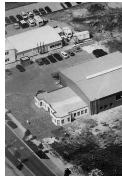
Erster Neubau in Achim mit 1.000 m 2 Hallen- und 300 m 2 Bürofläche.
